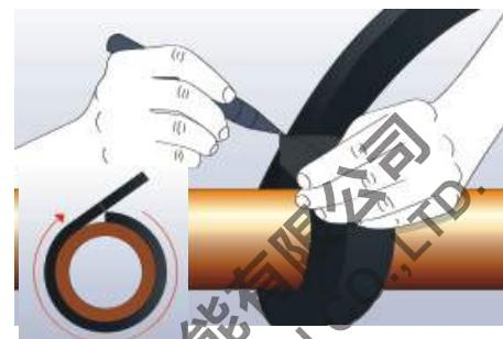
2、按照测量的尺寸，裁切 WinCell 赢胜橡塑板材。在接缝处薄且均匀地涂抹胶水，然后等待“初干”
