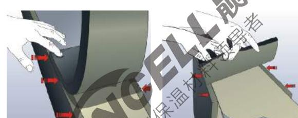
当 Wincell 赢胜橡塑初干时（指触法），把 Wincell 赢胜橡塑板材对好位置压紧在风管表面。继续在2个表面（包括 Wincell 赢胜橡塑接缝）涂胶水，初干后压紧。
