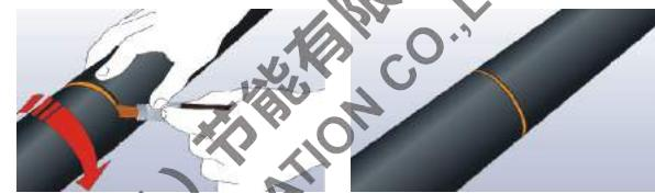
3、对于末端的接头的湿式安装，也可用手指扒开接头用小刷子把胶水均匀地涂在接缝表面，胶水不能涂得太厚。
