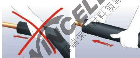
采用套管安装时，只能推保温管而不能拉伸它。如图所示。
